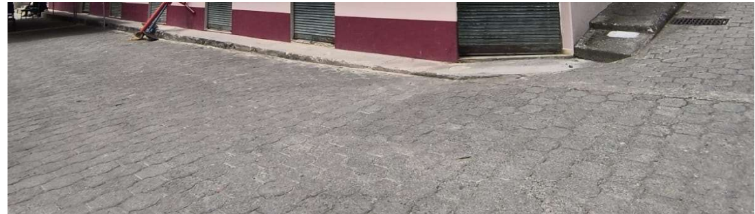
Fotografía 2.8. Capa de rodadura Tierra
