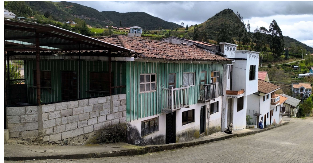
Fotografía 2.13. Estado de las viviendas.
